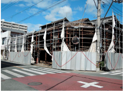
歴史的建築物の解体・除却中：土橋
