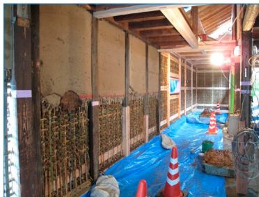
外壁の竹小舞と土壁
