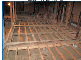
基礎・床組の修理
